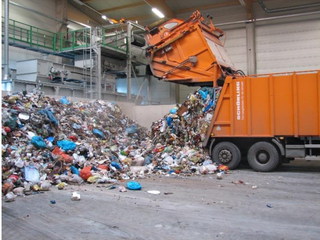
Bildnachweis: Ecowest, Anlieferungshalle und Hausmüll EBS Anlage
